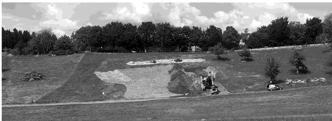
Auf dem Foto kurz vor Abschluss der Sanierung sind die Ausgleichsflächen gut zu erkennen. Steinhaufen für Reptilien oben im Hang und rechts unten auf dem Bild sowie Asthaufen am linken Bildrand.
