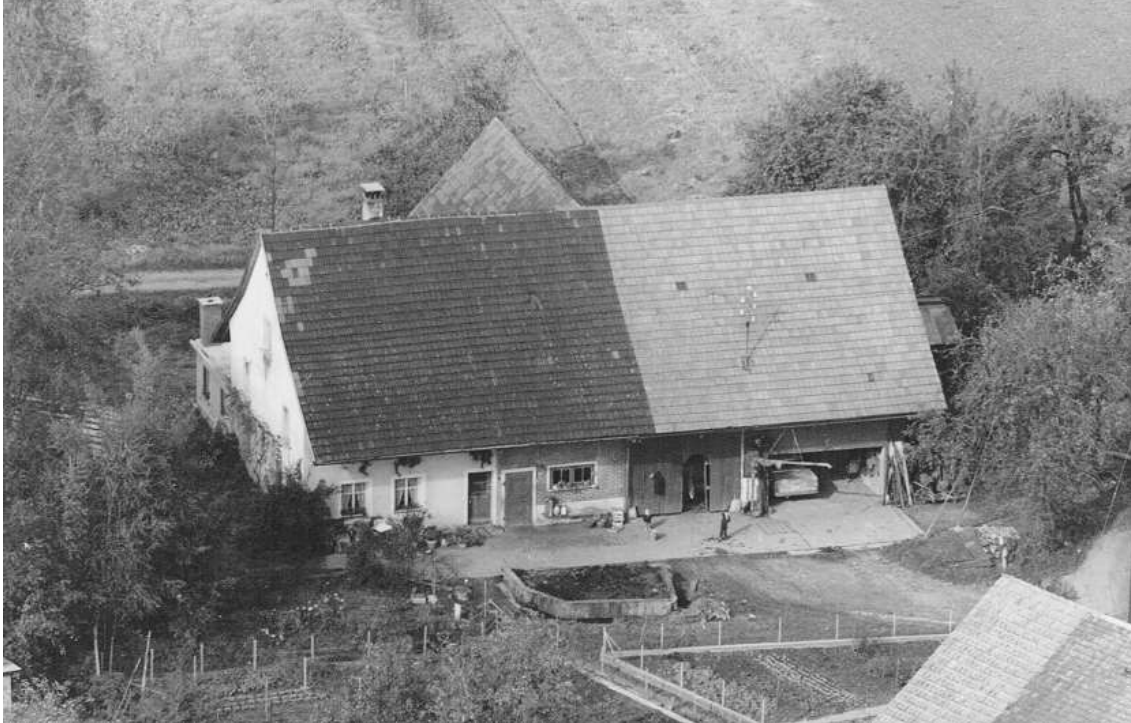
Der Annerhof wurde 1993 abgebrochen
