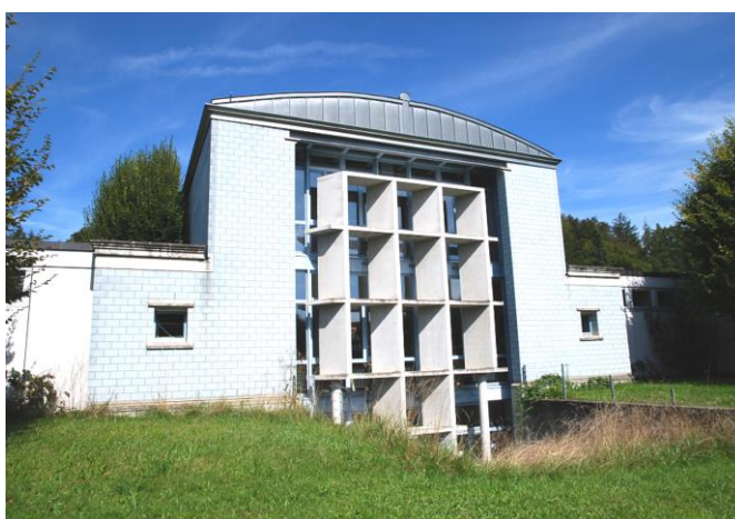
Bild Das „Blaue Schulhaus“ von Süden
