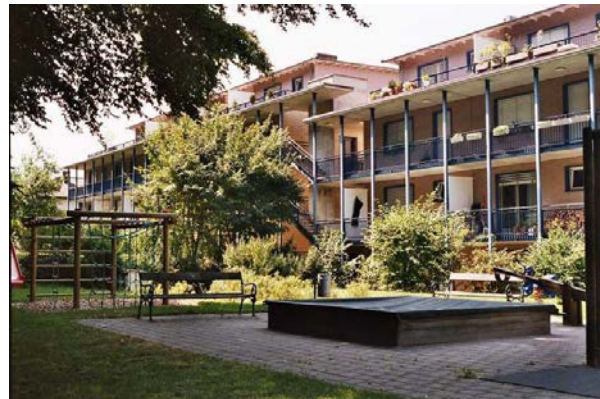
Bild Innenhof der Sonnengütli-Überbauung
