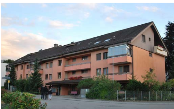
Bild Neubau Verzweigung Birdchstrasse/Jurastrasse
