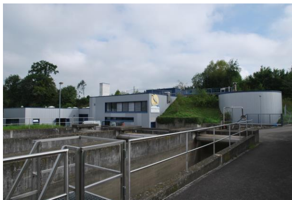
Bild Kläranlage Rehmatte, Birmenstorf
