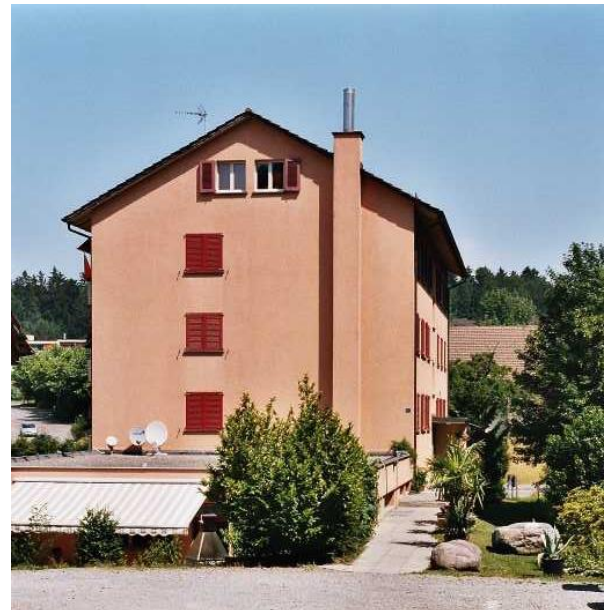
Bild Ferroblock an der Röhlerholzstrasse
