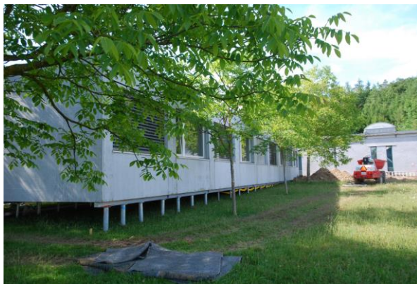
Bild Die neuen Schulpavillons zwischen Arche und Turnhalle
