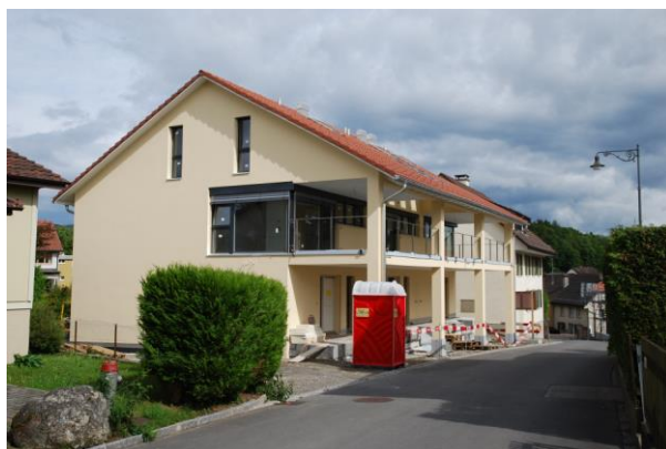
Bild Das neue „Neusiedler-Haus“ kurz vor Fertigstellung
