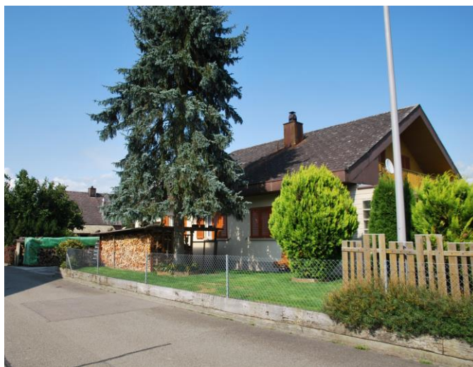
Bild Die ersten Häuser im Haberacher (Zustand 2014)
