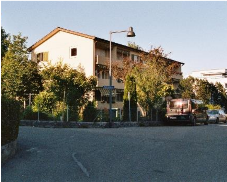
Bild Schneiderblock an der Hofstrasse
