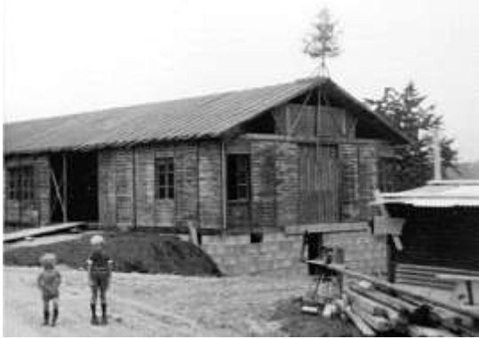
Das Aufrichtebäumchen ziert den Rohbau
